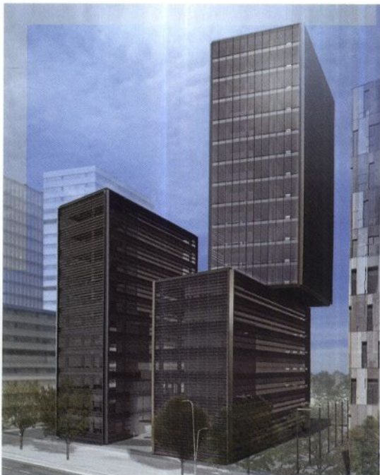
Edificio Oficinas. 22@ Barcelona
